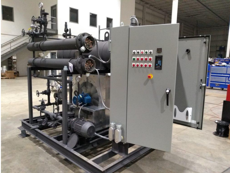
Fornecimento de unidades de Intervenção (Hot Oil)
